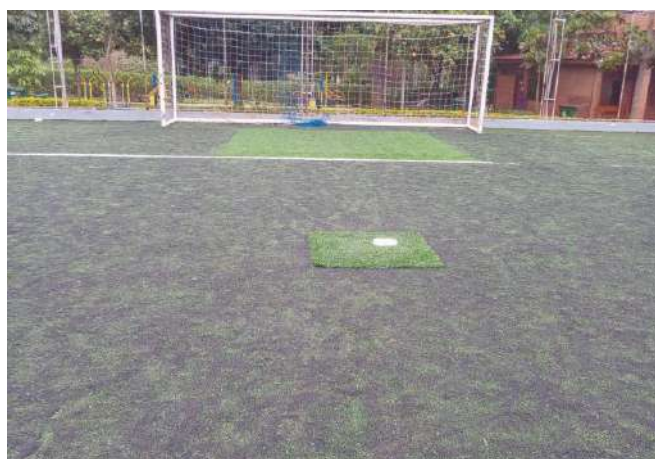
Figura 62: Gramado após manutenção
