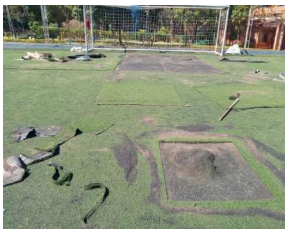
Figura 61: Reparo nos buracos do gramado do campo
